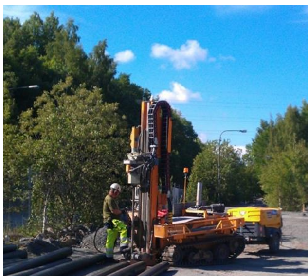
Figur 2: Borrbandvagn likt den som kommer att användas för arbetet.
