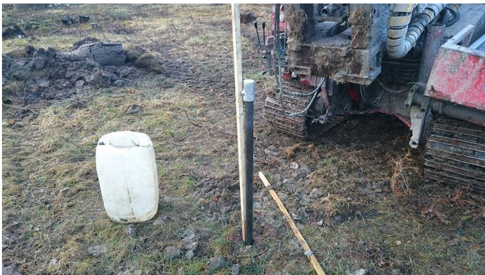
Figur 3: Grundvattenrör som kommer att installeras på enstaka ställen i området.
